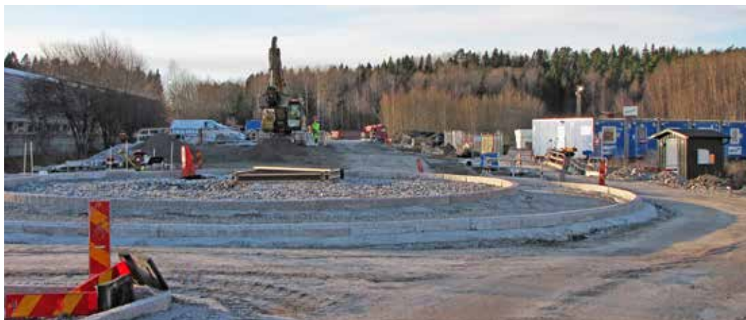
Pågående vägbygge, Växthusvägen 2016
