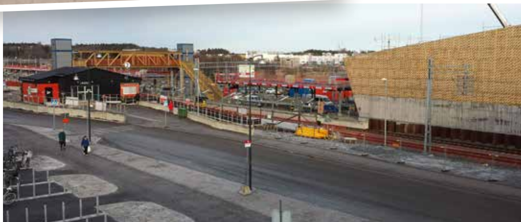
Nya Barkarbystation under byggnation 2015.
