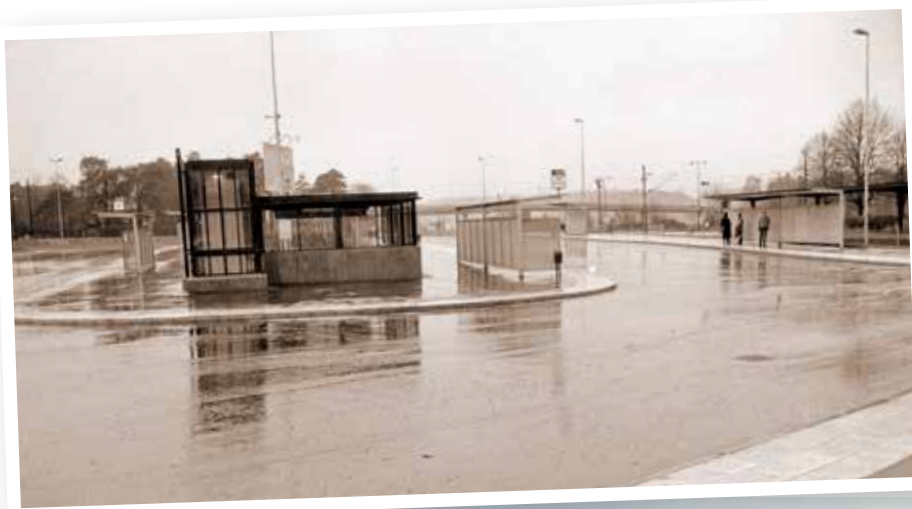
Bussterminalen vid Barkarbystation, bron över järnvägen i bakgrunden. Foto från år 1984.
